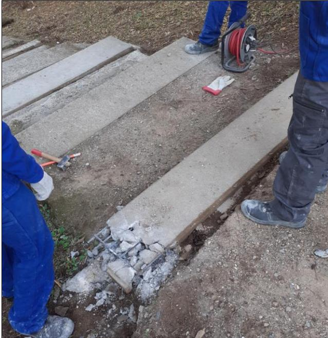
**Photo n°11 : dépose des marches existantes**
