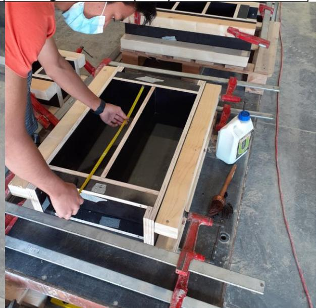
**Photo n°4 : coffrage des grandes claustras / Préparation avant coulage : vérification par suivi d'une fiche qualité**
