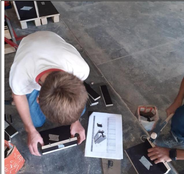
**Photo n°1 : assemblage des éléments de coffrage claustras**
