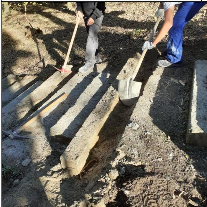
**Photo n°13 : dépose des contremarches existantes**
