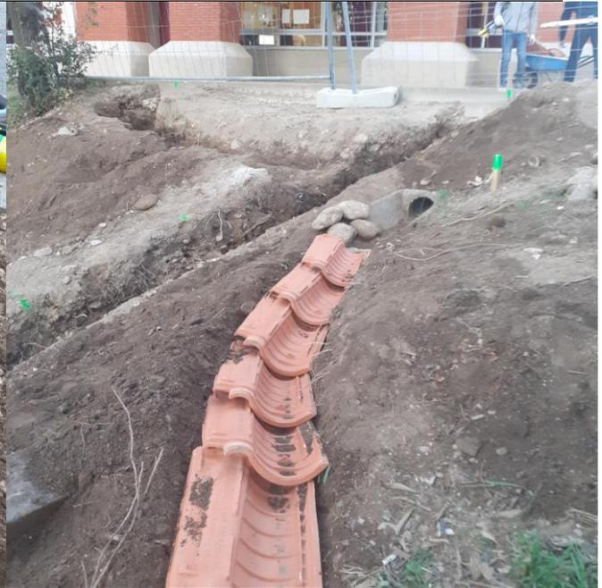
**Photo n°19 : déviation réseau Eaux Pluviales (ouvrage provisoire)**
