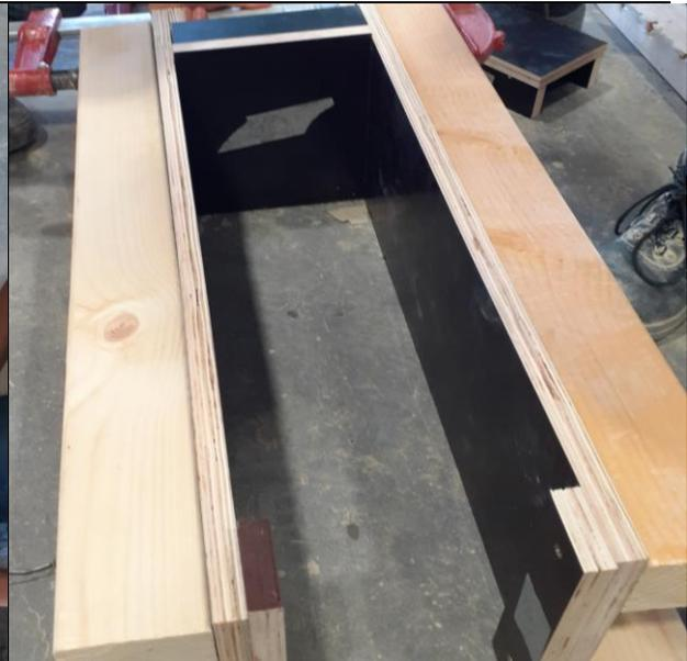
**Photo n°2 : assemblage des éléments de coffrage claustras (suite)**
